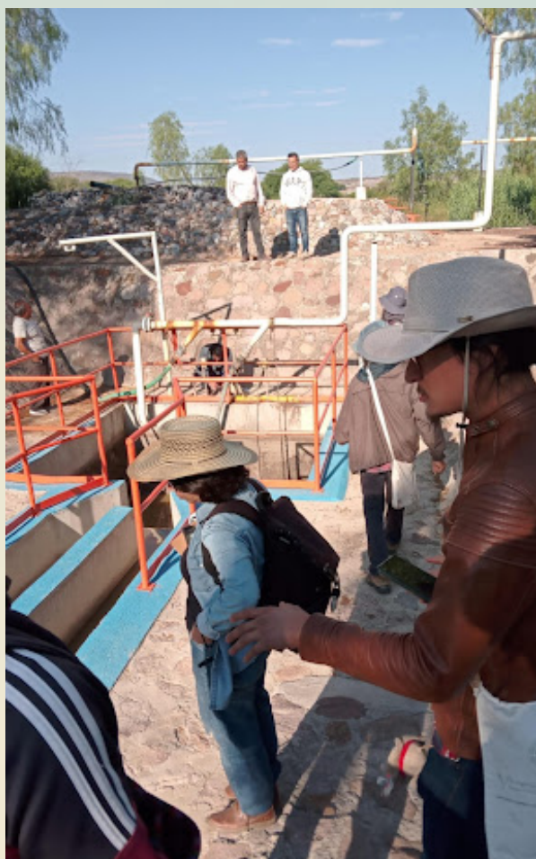
Fotografía: Planta de tratamiento de aguas residuales de San Pablo Tolimán
