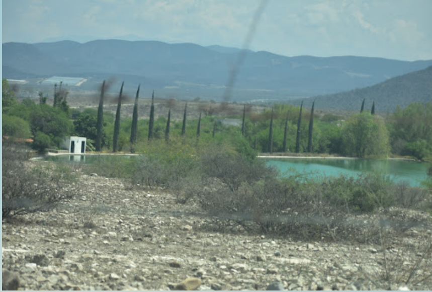
Fotografía: Presa construida en los Cedazos. Daniela Villalpando abril 2023.
